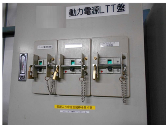
図 206 元電源の不意起動防止の事例
